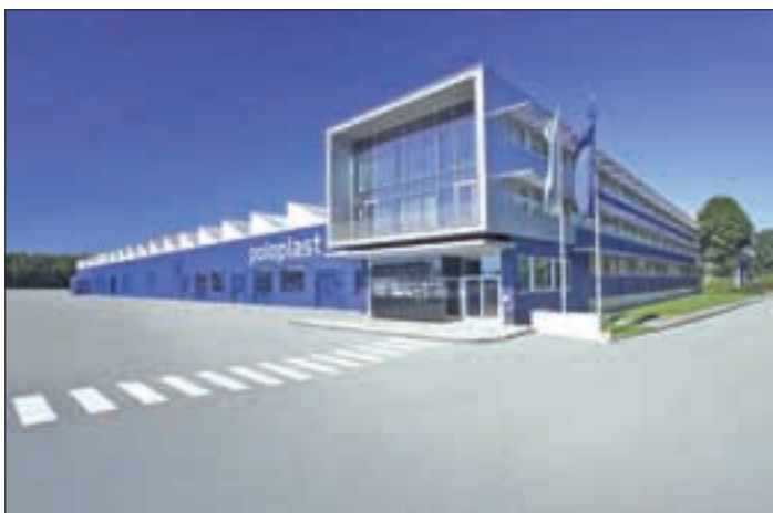
Poloplast Zentrale in Leonding, Oberösterreich
